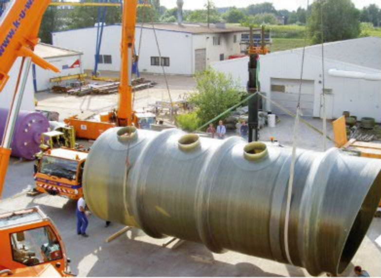
GFK Kühlwasserleitung RWE Eemshaven
